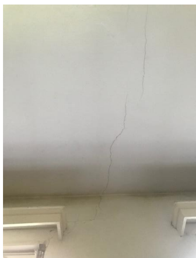
3. épületrész, falról a födémre áttérjedő repedés
