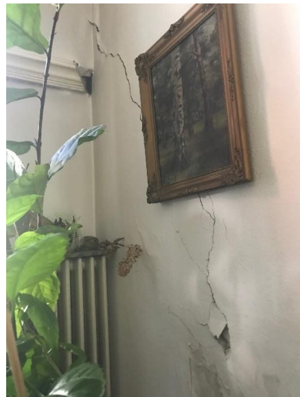
3. épületrész falsarok, átmenő repedés kívülről - belülről
