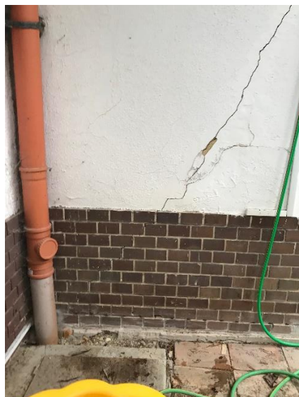
3. épületrész fenyőfa melletti sarok süllyedése
