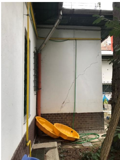
3. épületrész fenyőfa melletti sarok süllyedése
