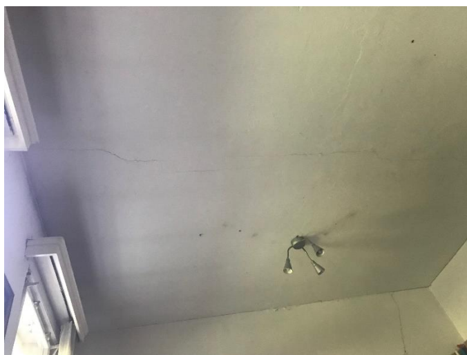
3. épületrész, falról a födémre áttérjedő repedés
