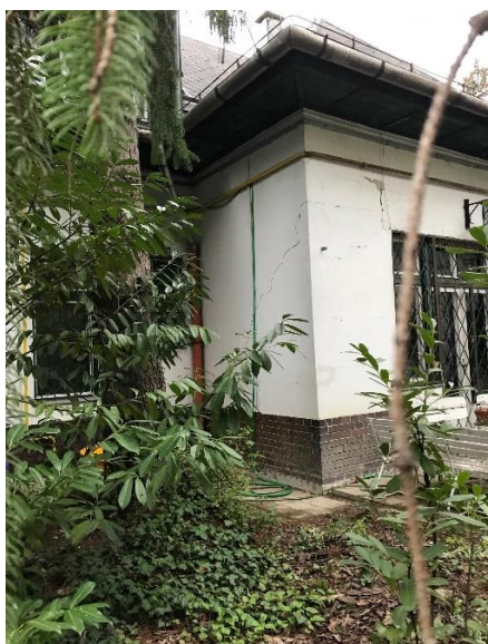
3. épületrész falsarok, átmenő repedés kívülről - belülről
