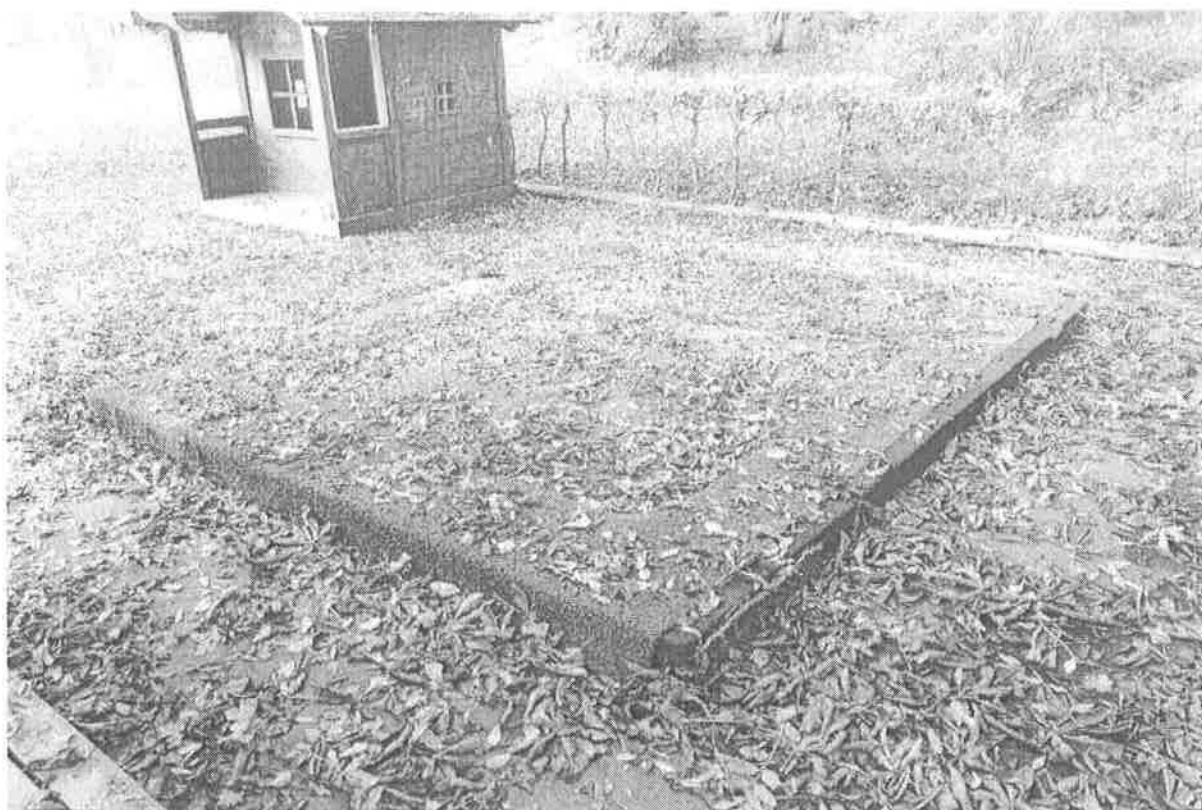
12. Beton talpazat - Elbontandó, mert balesťveszélyesen kiemelkedik, így botlásveszélyes.
