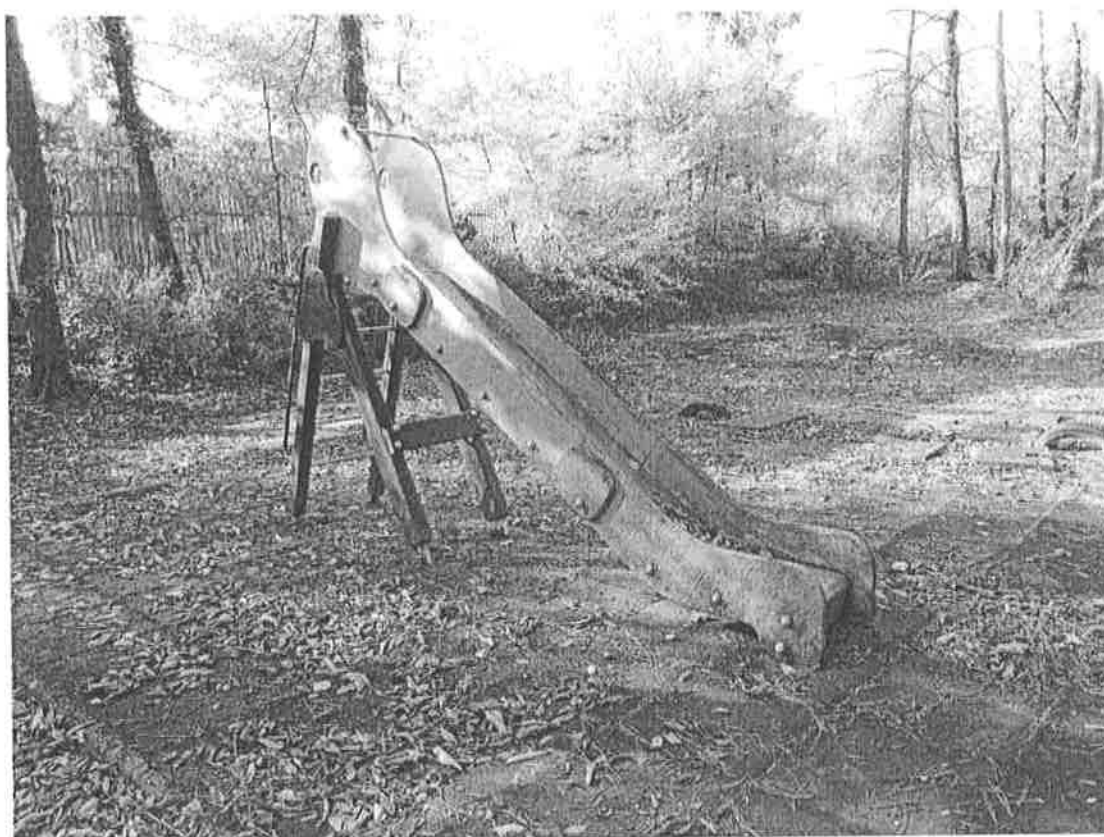
7. Csúszda - Elbontandó, rossz állapotúak a fa alkatrészei, gazdaságosan nem újítható fel.
