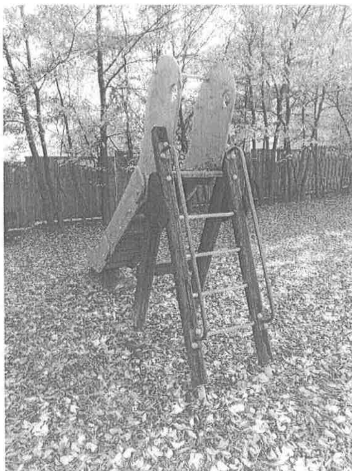
10. Csúszda - Elbontandó, rossz állapotúak a fa alkatrészei, gazdaságosan nem újítható fel.
