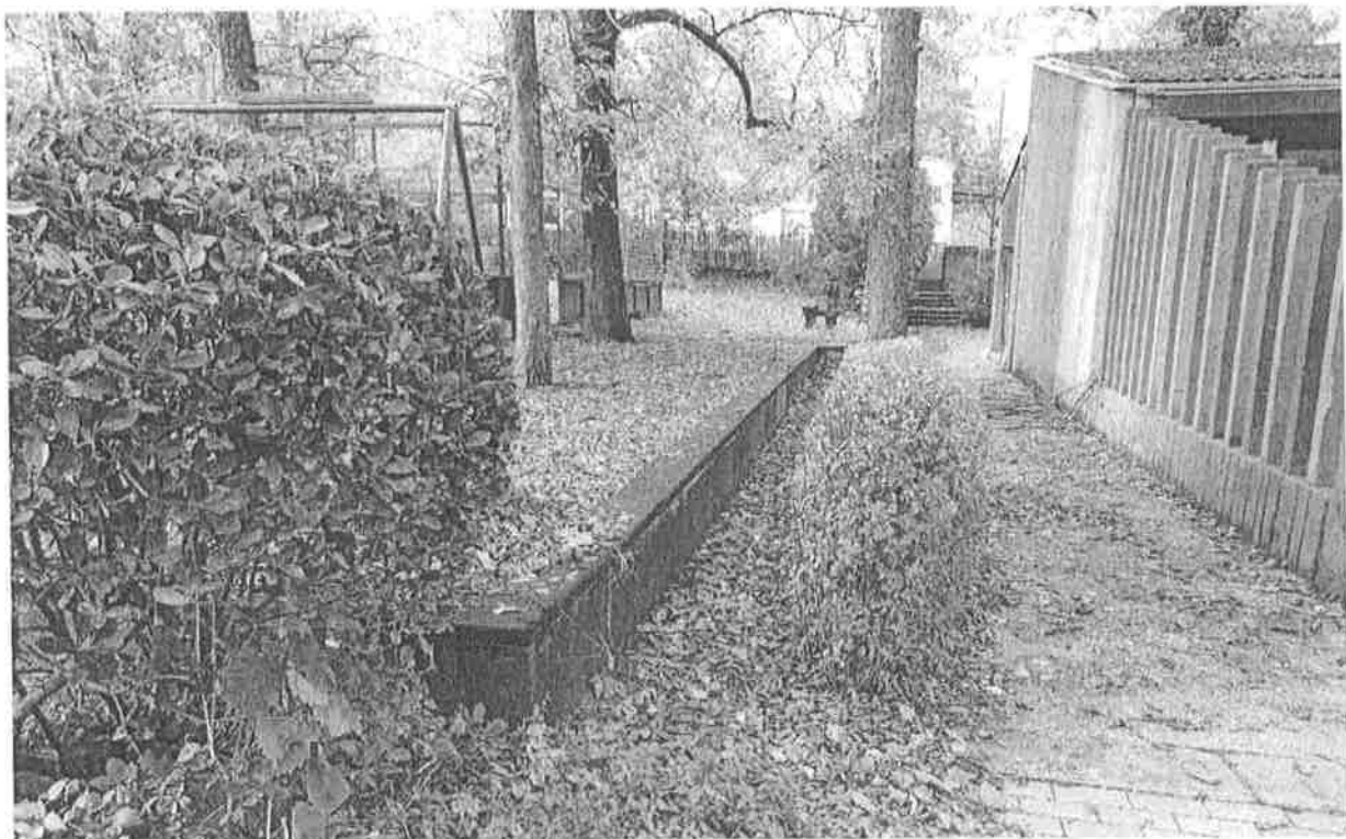
2. Támfal és sövény - Elbontadó, egy szintben kell csatlakoznia a rézsűnek az udvarral. A jelenlegi megoldás botlásveszélyes.
