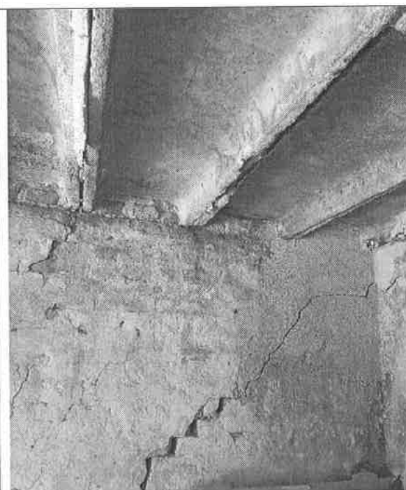
A panelek közötti réseket hungarocellel próbálták betömödni.
