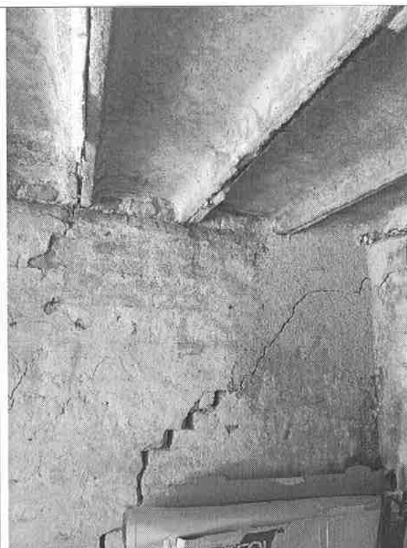
A teherhordó falon, a sarokban süllyedésre utaló, 45°-os repedés.
