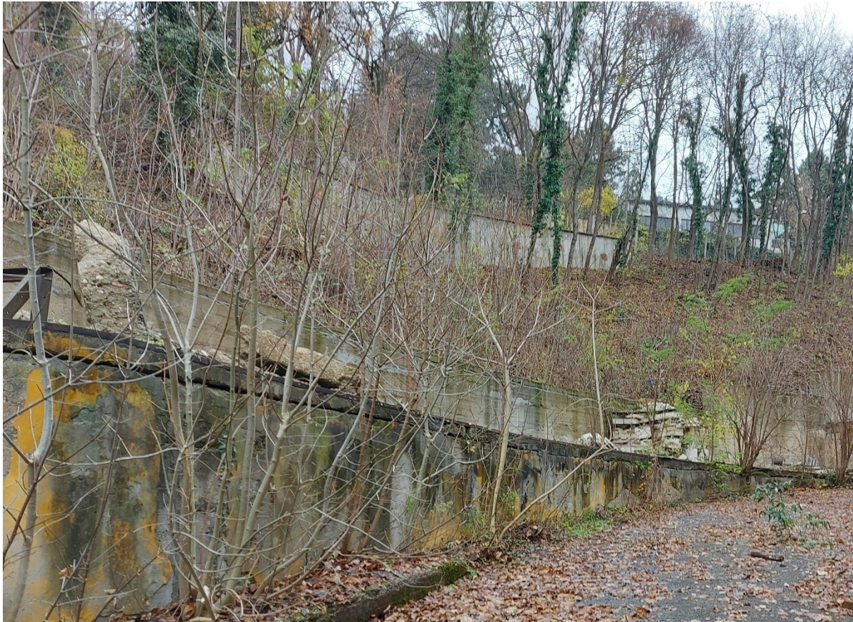
56. ábra: A Szalonka út útburkolatának állékonyságát védő meglévő támfal a 11663/40 ingatlanon
