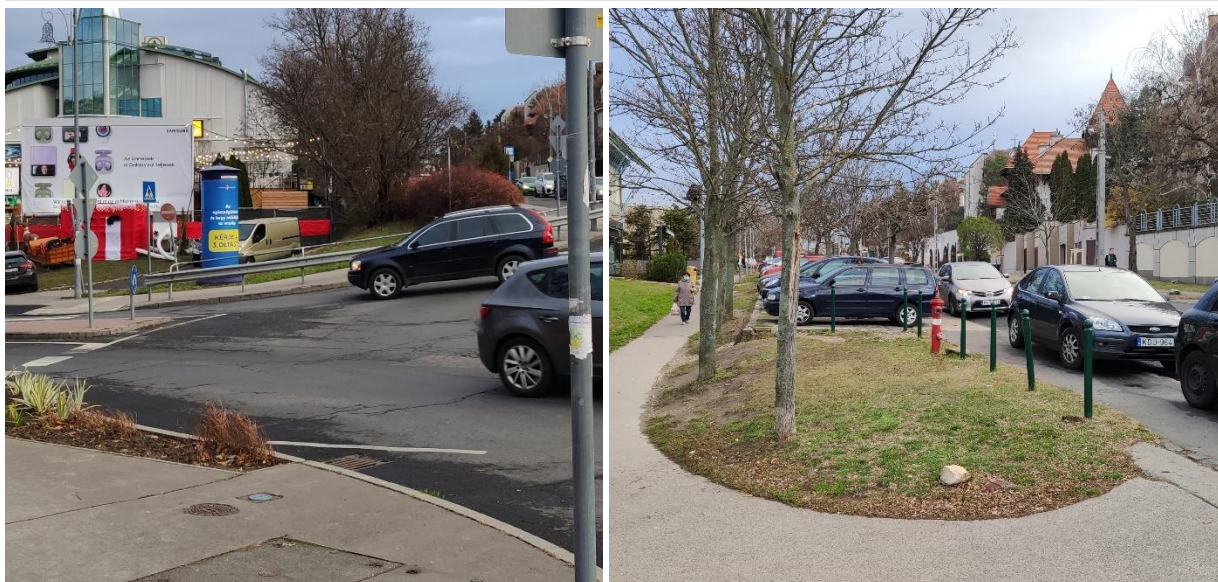
Földalatti és föld feletti tűzcsap kialakítása a terület környezetében
