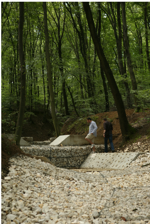
Csapadékvíz-elvezető műtárgy Budaligeten
