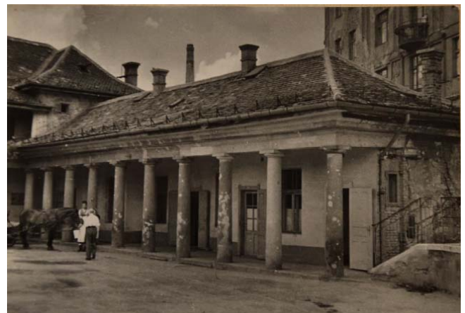
A klasszicista épületszárnyak feltárulása 1958? forrás:építéstudományi dokumentáció
