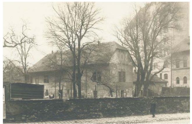
Az elbontott barokk épületszárny az 1910-es években forrás:építéstudományi dokumentáció, Kiscelli Múzeum, Fényképgyűjtemény
